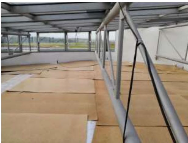
Abbildung 3. übliche Lösung zur Schließung von Lücken auf Arbeitsebenen
