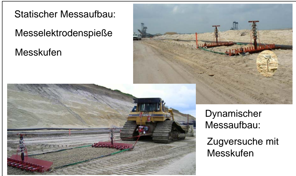
Abbildung 8: Messaufbau für statische und dynamische Geoelektrikversuche
