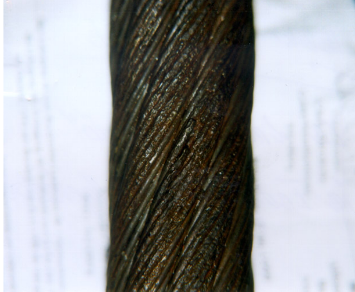
Abbildung 2: korrodiertes, verzinktes Rundlitzenseil - Untertorantrieb der Schleuse Eibach
