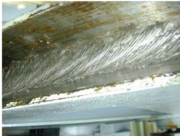
Abbildung 3: Stahlscheibe - Obertorantrieb Schleuse Hippoltstein
